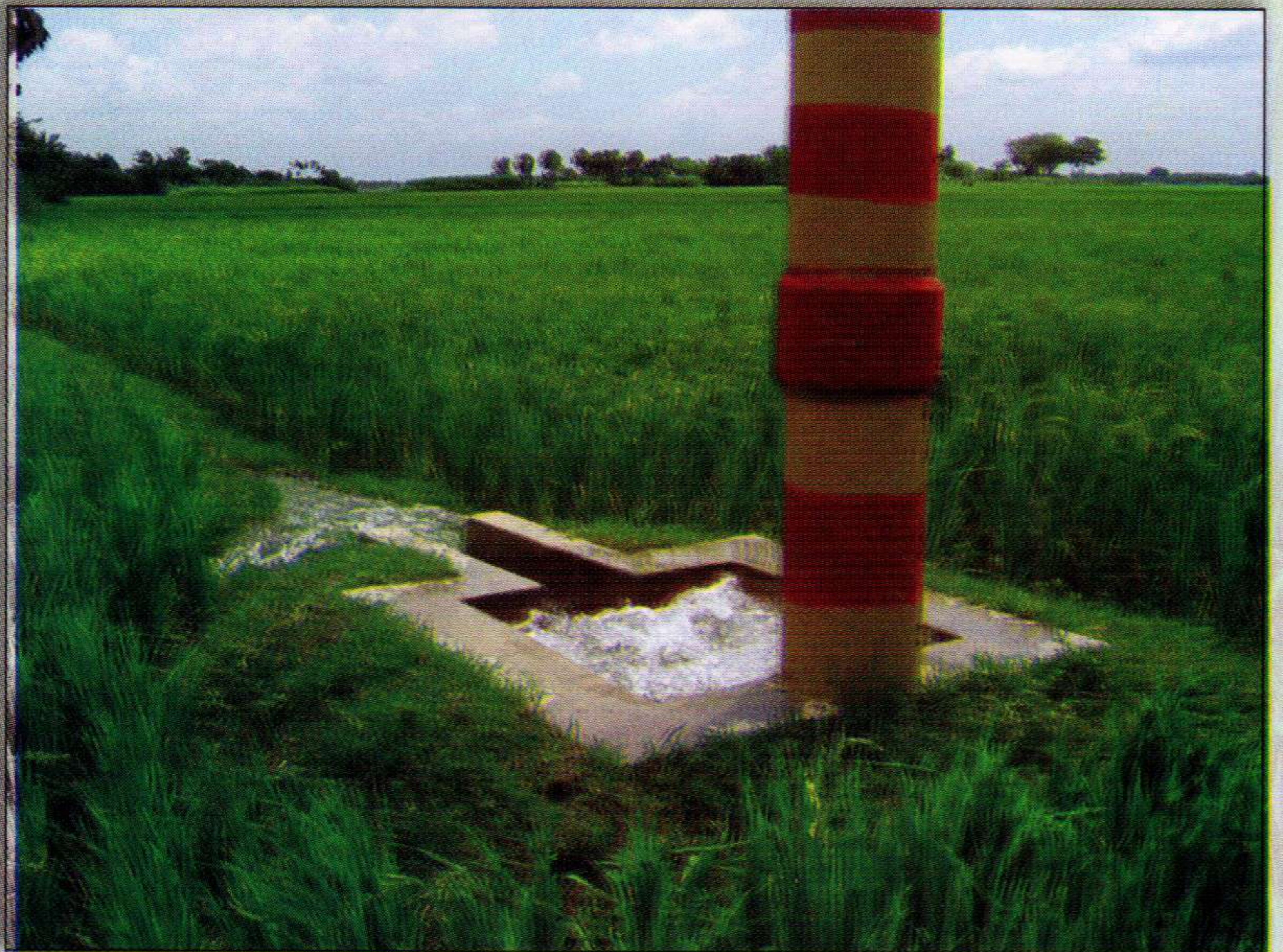
পানি অপচয়রোধী বি.এম.ডি.এ-এর গভীর নলকূপের পানিসঞ্চালন আন্ডারগ্রাউন্ড পাইপ লাইন ।
